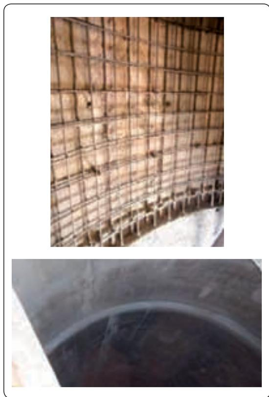
Figure 41 : Création d'une paroi interne dans une cellule (à g. : vue du ferrailage ; à d : vue de la paroi terminée)
