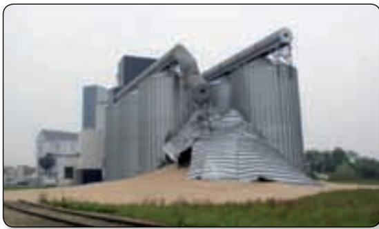
Figure 2 : Ouverture d'une cellule métallique
