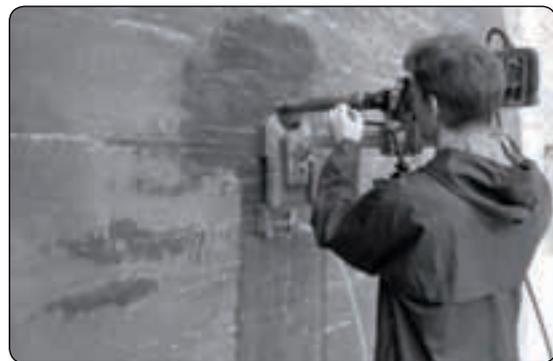
Figure 30 : Carottage dans une paroi en béton
