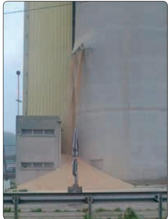
Figure 3 : Epandage de grains suite à l'ouverture partielle d'une cellule
