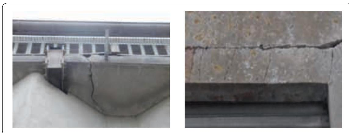
**Figure 18 : Cas de fissures structurelles**
