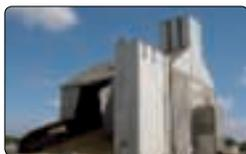
Figure 4 : Epandage de grains suite à l'ouverture totale d'un silo palplanche ayant impacté une canalisation GPL
