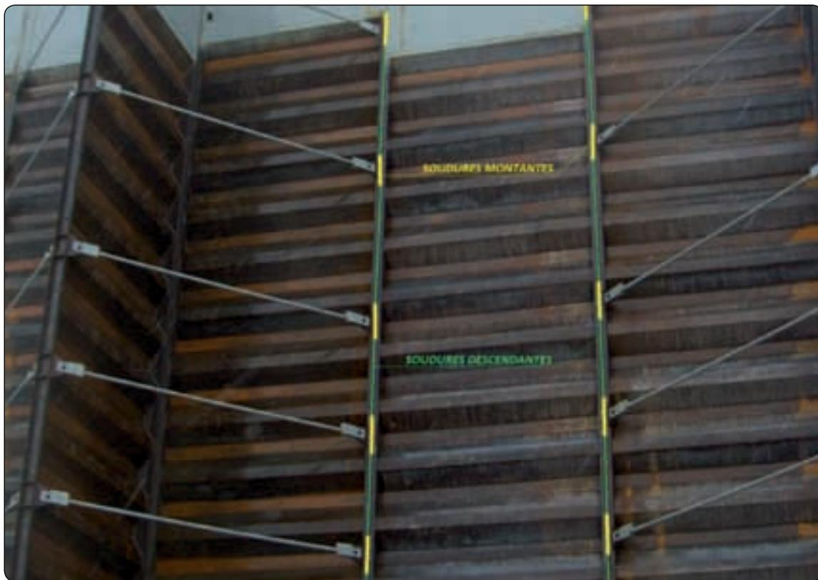
Figure 48 : Soudures sur un silo palplanche
