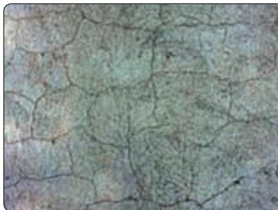
**Figure 17 : Fissuration superficielle (faïençage)**
