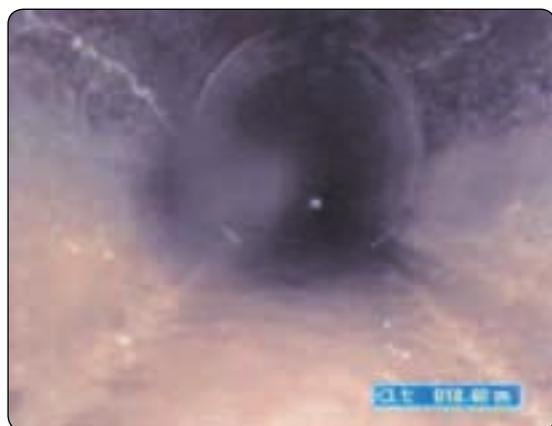
Figure 29 : Conduit fissuré
