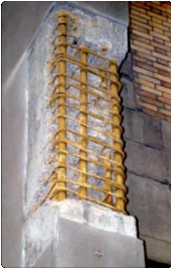
Figure 44 : Vue d'armatures dégagées et traitées
